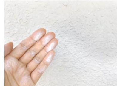
**原因：**紫外線・温度・水などが長時間作用して、塗膜表面の樹脂や顔料が劣化し、主として白色の粉化物が表層に付着したものです。
